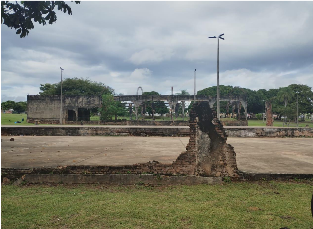
Figura 2: Ruínas fábrica Cimba, localizada Parque que leva o mesmo nome
