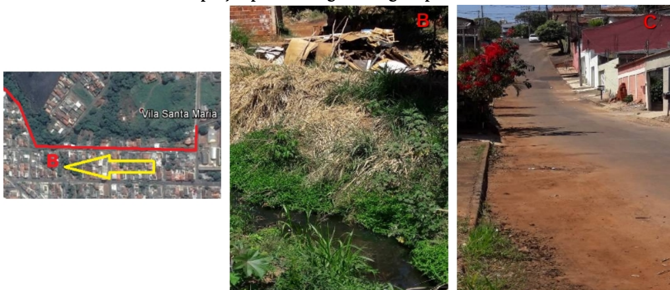
Figura 5 – Ponto B do trecho do Córrego Catingueiro, depósito irregular de resíduos em B e rua sem captação para drenagem de águas pluviais em C.
