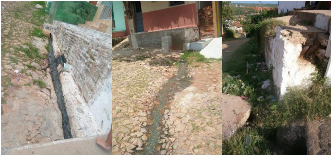
Figura 1 – Esgotos a céu aberto
