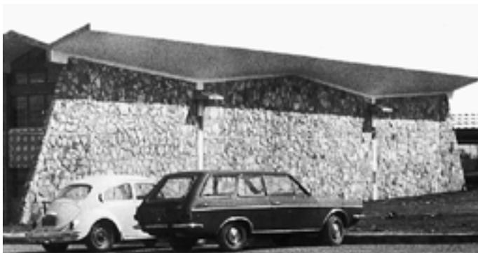
Fig. 16: Alvenaria de pedra nas laterais do edifício. Fonte: Acervo do CEPAE/UFMG
