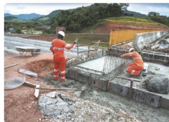
Pedreiros trabalhando em construção no município de Silva Jardim (RJ), 2018.
