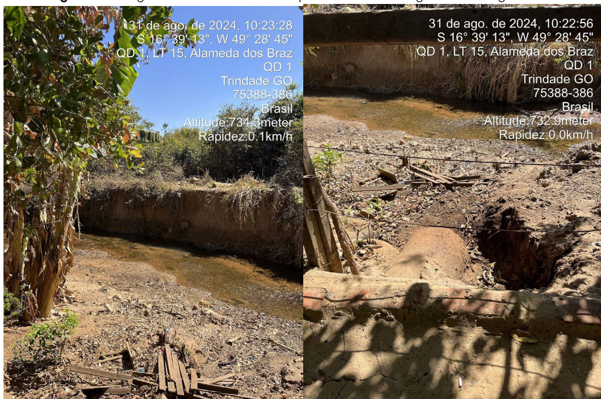
Figura 3 – Imagem do barranco formado pela erosão da margem do Córrego Bruacas
