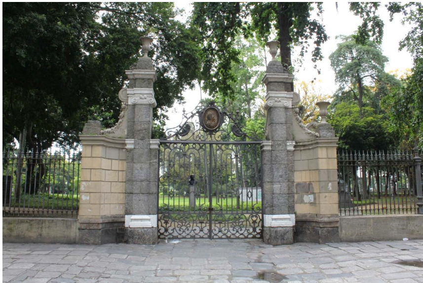
Figura 7 - Fotografia do portão do Passeio Público em ferro fundido.
