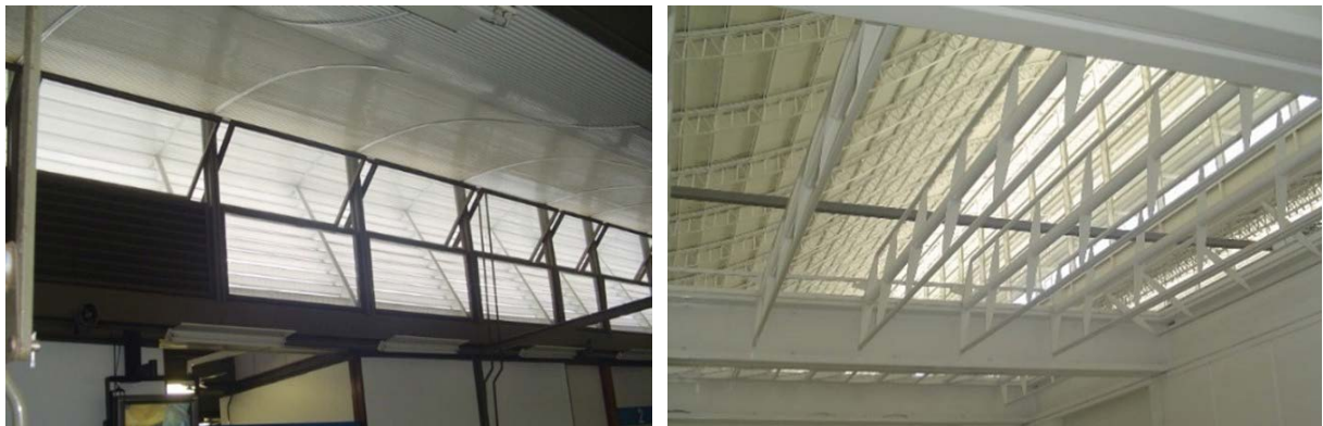
Figura 17 - venezianas e a substituição por vidro em Salvador e vidros no Rio, respectivamente.
