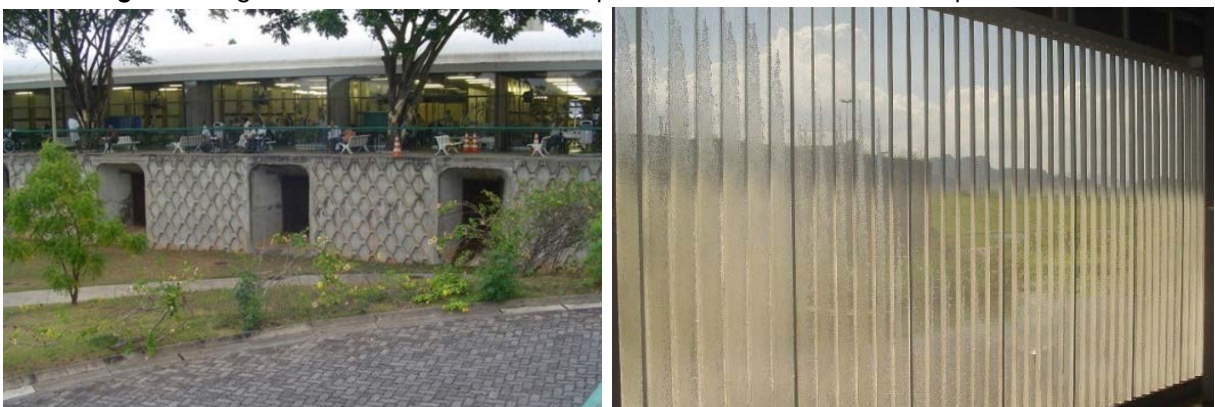
Figura 14 - galerias do Sarah-Salvador e piso técnico do Sarah-Rio, respectivamente
