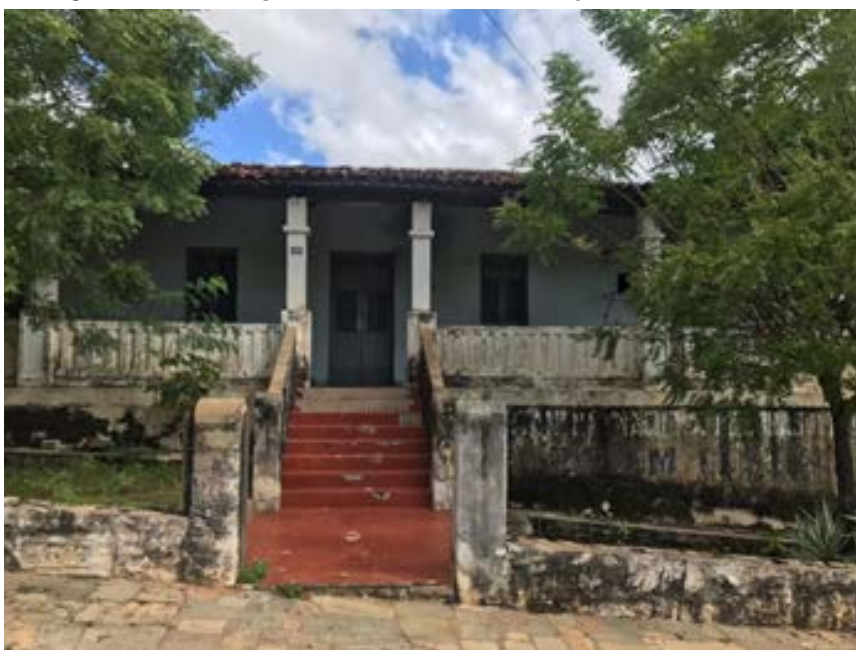
Figura 2 - Edificações históricas do Município de Coremas, PB.
