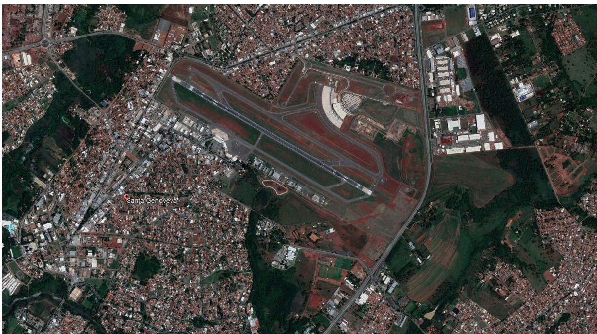
Figura 4 - Aeroporto Santa Genoveva após expansão em 2017 – Imagem Geral.
