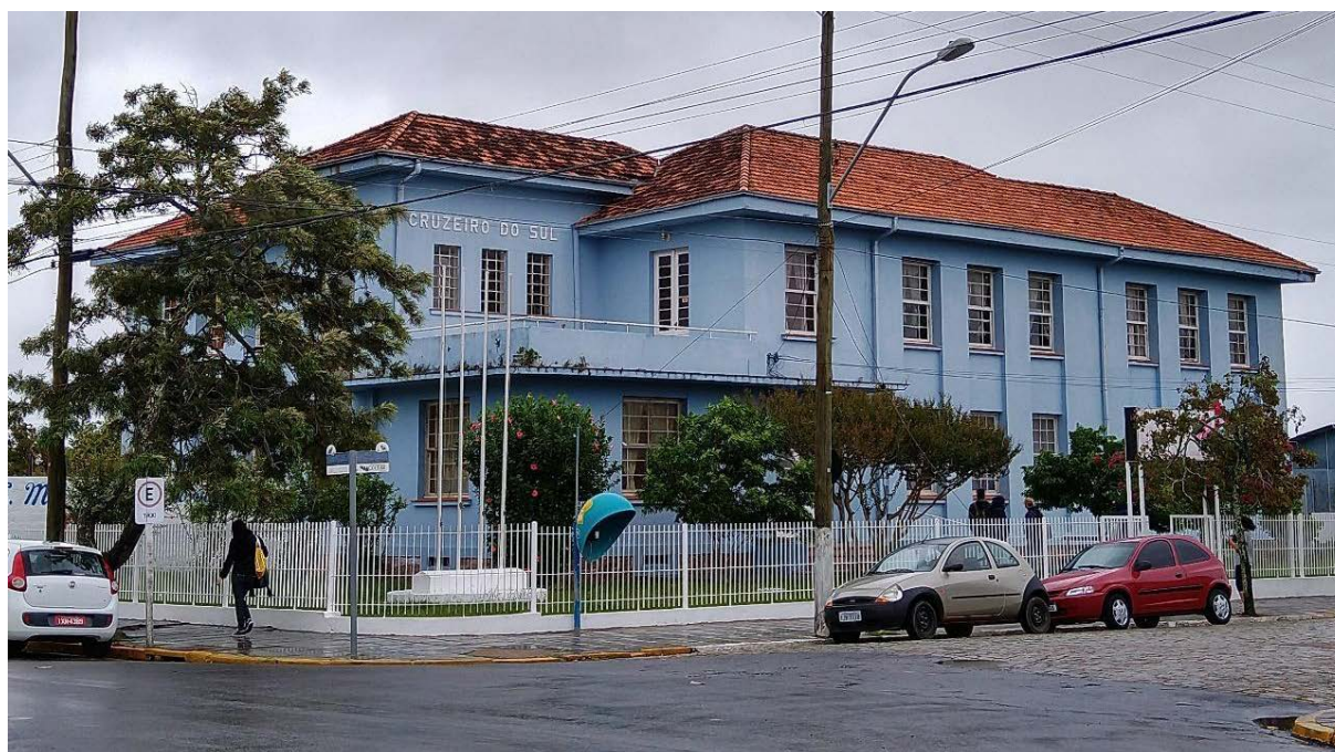
Figura 5 - Fachada Instituto Estadual de Educação Cruzeiro do Sul.
