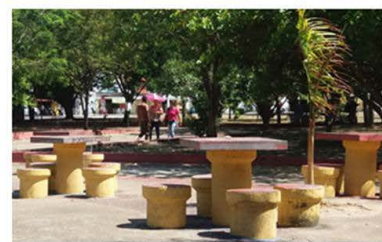
Bancos e mesas em concreto armado
