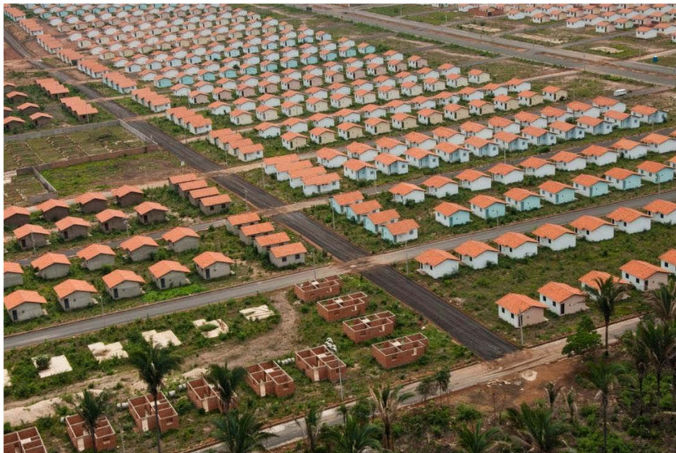
ILUSTRAÇÃO 05: IMAGEM AÉREA DO CONJUNTO HABITACIONAL RESIDENCIAL JACINTA ANDRADE DURANTE SUA CONSTRUÇÃO . Fonte: LUZ (2016)
