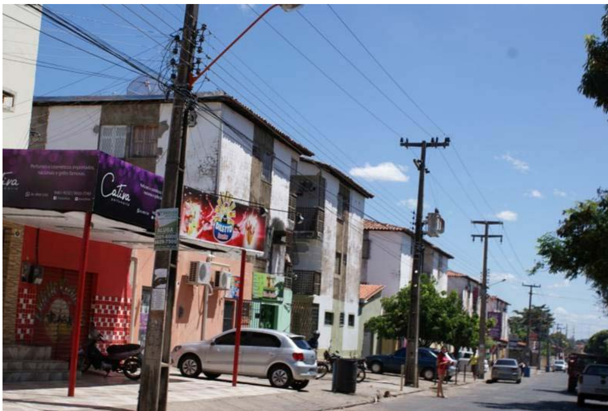
ILUSTRAÇÃO 03: CONJUNTO MORADA NOVA, DE BLOCOS MULTIFAMILIARES, LOCALIZADO EM TERESINA. Fonte: PIAUÍ HOJE (2017).
