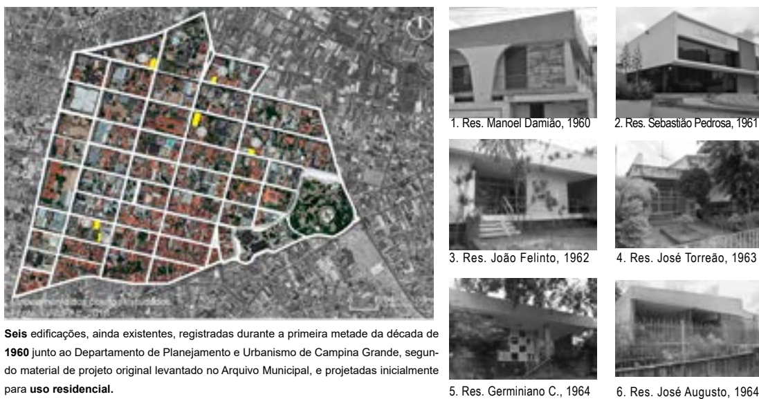
Ilustração 04: Parte do acervo residencial moderno construído na década de 1960 no bairro da Prata. Fonte: Elaborado por GARCIA, M. 2018.
