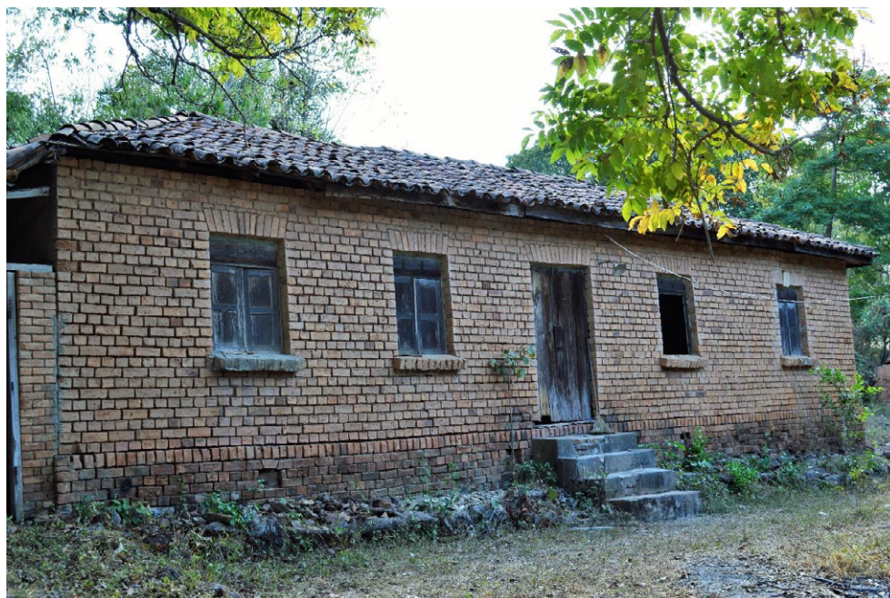
Figura 4- O efeito plástico dos tijolos à vista se harmoniza com as aberturas de vergas retas compostas por fileiras de tijolos dispostos em posição vertical, nessa habitação que documenta a fixação de imigrantes alemães na Colônia de Uvã, no século XX.
