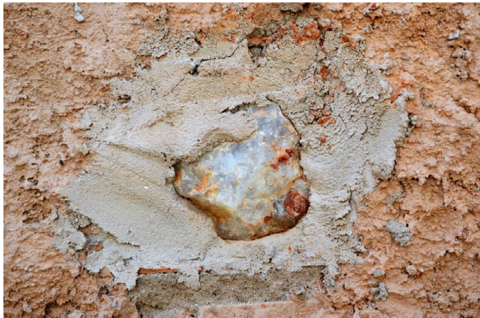
Figura 1.2- Pedaco de quartzo utilizado na vedação de buraco na parede lateral externa, evidenciando simplicidade e criatividade na utilização de materiais disponíveis no entorno imediato do construtor. Fonte: Acervo do autor, 2014.
