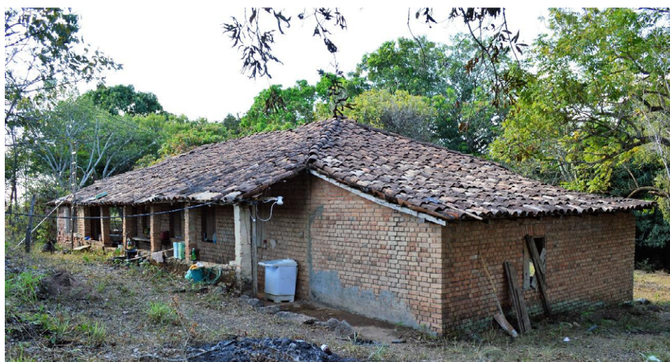
Figura 4- As tradições construtivas dos imigrantes alemães da Colônia de Uvã se combinaram com as tradições construtivas locais, como no uso de coberturas de telhas coloniais generalizadas no Brasil desde o período colonial.
