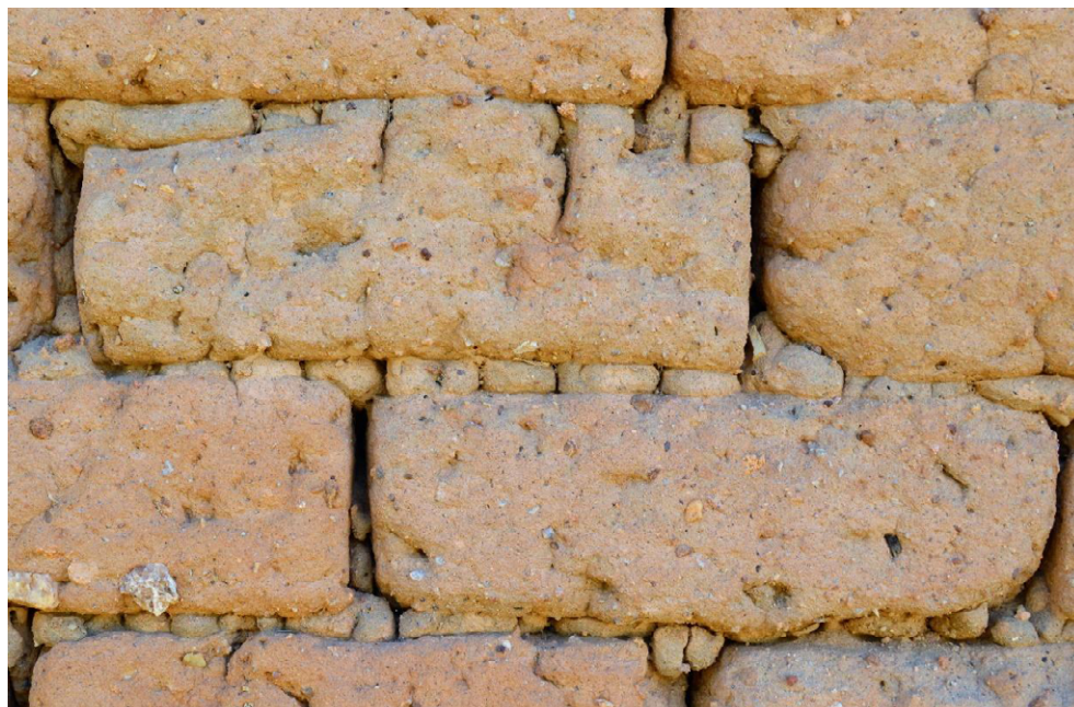
Figura 2.2- As pedras miúdas misturadas ao barro tornam esses blocos de adobe semelhantes aos de edificações erguidas em adobe e taipa de pilão, nos séculos XVIII e XIX, em Goiás Velho. Fonte: Acervo do autor, 2014.
