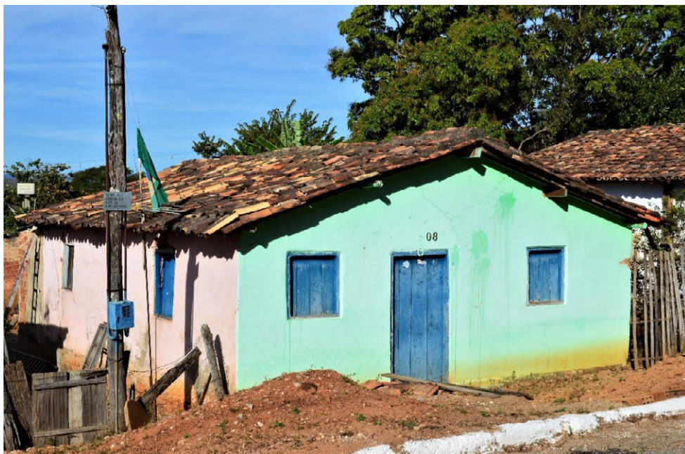
Figura 1- Habitação no Distrito-Sede (cidade de Goiás Velho), com janelas de uma folha de madeira que se abre para o interior, tipologia que remonta ao início do processo de colonização e é denominada janela de escudo.
