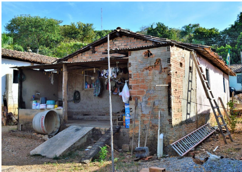
Figura 1.3- Além de blocos de adobe e tijolos maciços, a mesma habitação emprega tijolos cerâmicos vazados, mostrando a capacidade de adaptação do construtor no uso combinado de diferentes materiais construtivos contemporâneos e tradicionais. Fonte: Acervo do autor, 2014.
