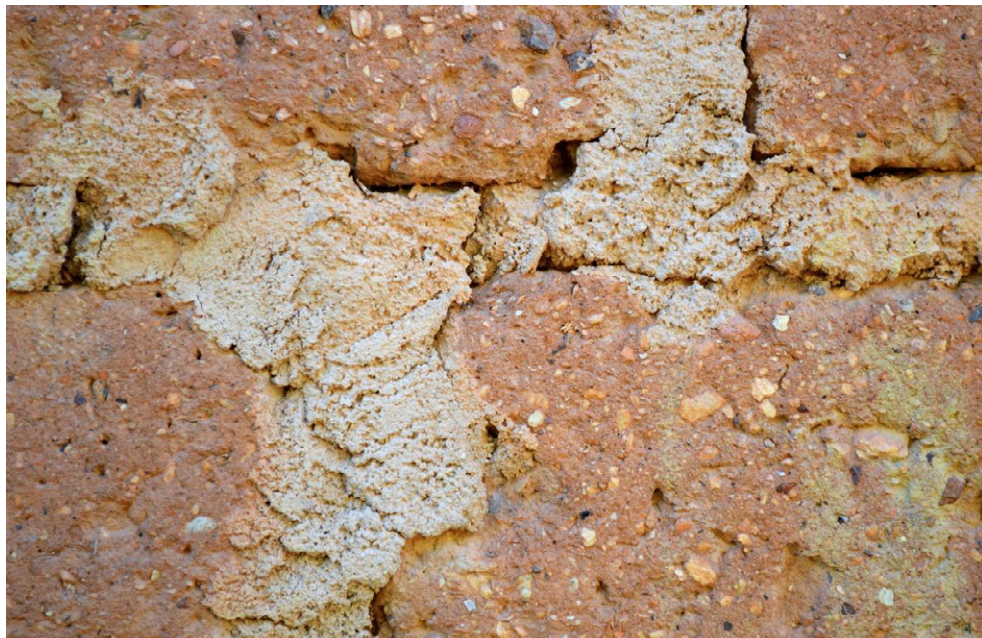
Figura 3.1- Na parede lateral da habitação, o distanciamento da tradição construtiva colonial se mostra no uso de argamassa de cimento no assentamento dos adobes fabricados pelo morador, ao mesmo tempo em que a existência de pedras miúdas misturadas ao barro assemelha os blocos de adobes àqueles encontrados em edifícios dos séculos XVIII e XIX, em Goiás Velho.
