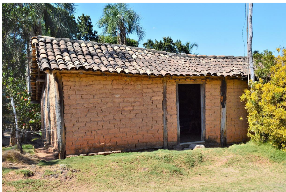
Figura 2- Na Colônia de Uvá, essa habitação mostra a permanência de elementos do sistema construtivo colonial, nas paredes de adobe, na cobertura de telhas coloniais (capa e canal ou canudo ou romanas), no telhado de duas águas e na cumeeira paralela a fachada principal, com telhas longitudinais argamassadas cobrindo o encontro de duas águas.
