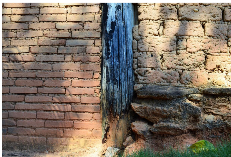
Figura 2.1- As paredes de tijolo e de adobe correspondem a fases construtivas distintas, mas o conhecimento técnico tradicional se manifesta no uso de fundações de pedra para preservar o adobe da umidade, assim como no emprego da argamassa de terra tanto no assentamento dos tijolos quanto no dos adobes.
