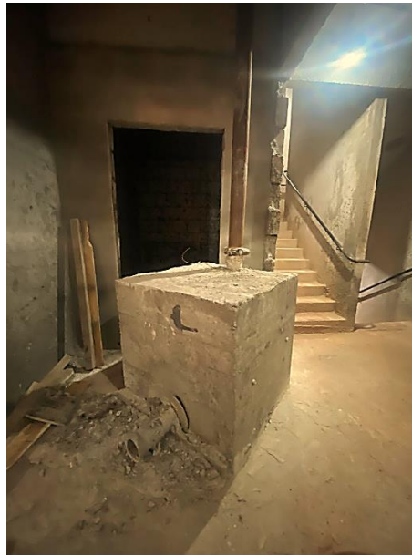
FIGURA 1: Linha de bombeio fundida no bloco de concreto FONTE: disponibilizada pelo engenheiro responsável pela obra, março de 2022.
