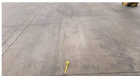
FIGURA 10 - Fissura por retração - região 40
