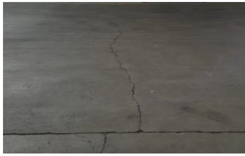
FIGURA 37: Fissura por retração - região 11.
