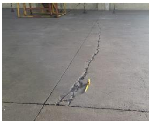
FIGURA 15: Fissura por retração - região 27.
