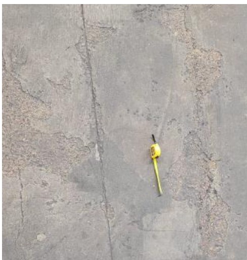
FIGURA 7 - Delaminação - região 31
