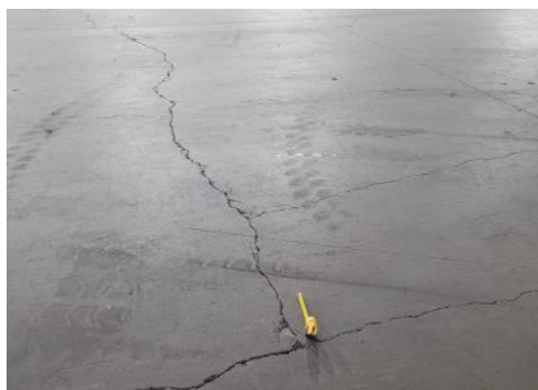
FIGURA 43 - Fissura por retração - região 9.
