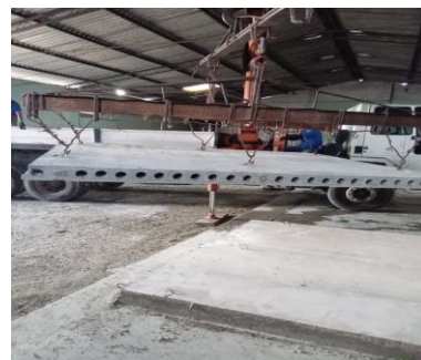
FIGURA 8 – Içamento com Munck
