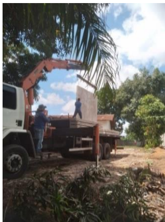
FIGURA 12 – Manuseio dos painéis
