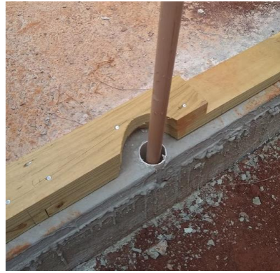
FIGURA 12: Camisa para passagem da tubulação de água fria FONTE: A autoria própria (2020)
