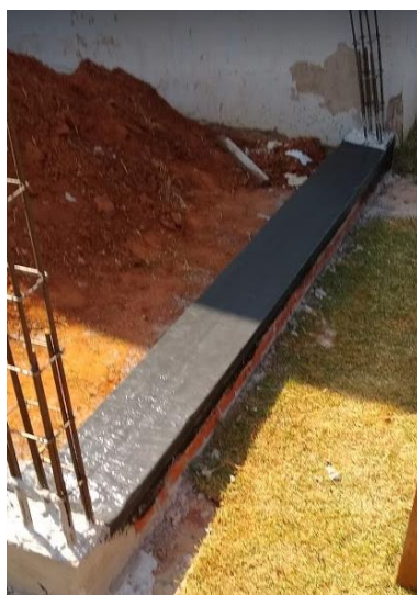
FIGURA 2: Baldrame com manta asfáltica aplicada FONTE: Autoria própria (2020)
