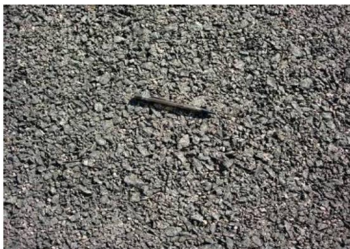
FIGURA 5 – Concreto Asfáltico Poroso
