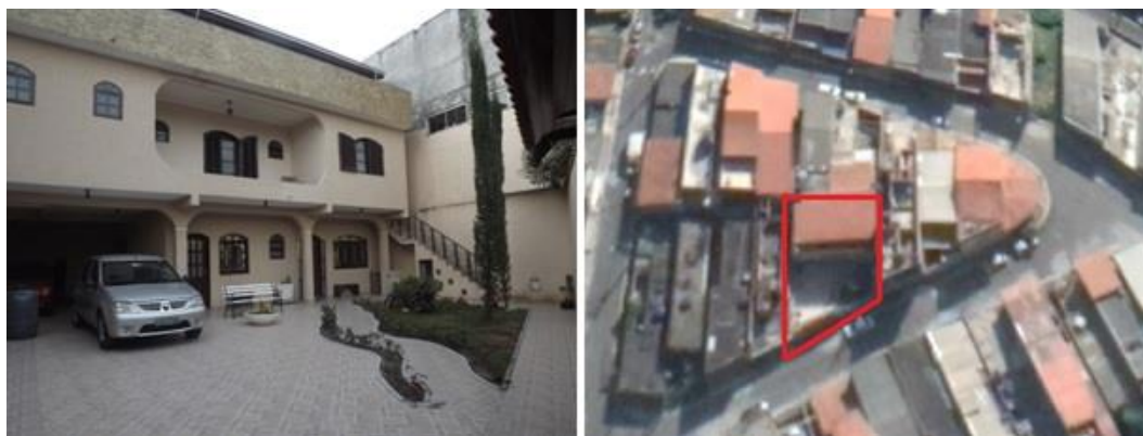
FIGURA 2: Fachada da Residência e vista aérea
