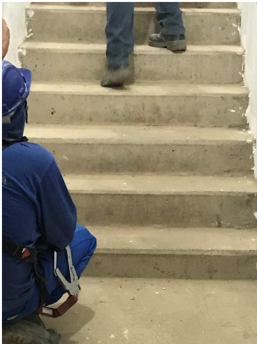
FIGURA 11: Nivelamento da escada na obra B. FONTE: Autoria própria/Obra B.
