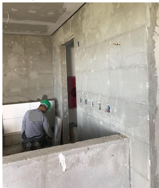
FIGURA 9: Retirada do revestimento da cozinha para adequação do projeto na obra A.
