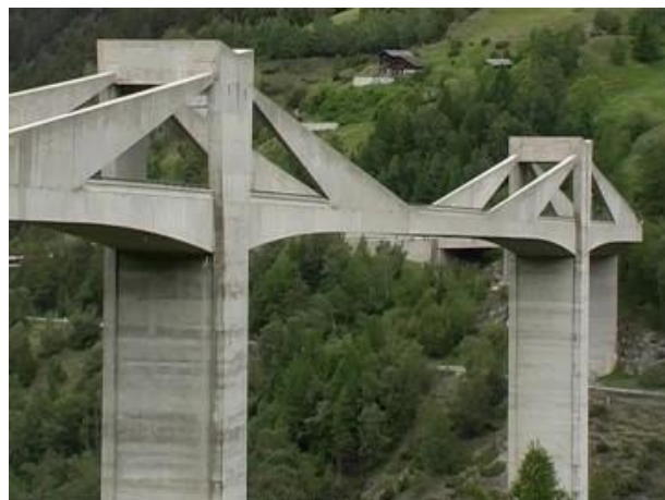
FIGURA 9: Pilares contínuos em torno da plataforma.
