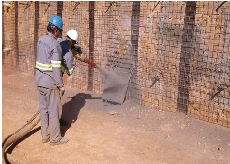
FIGURA 9: Moldagem de placa de concreto projetado para verificação de resistência axial.
