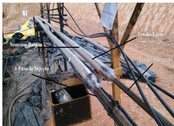
FIGURA 6: Detalhes da montagem dos chumbadores teste para ensaio de arrancamento.
