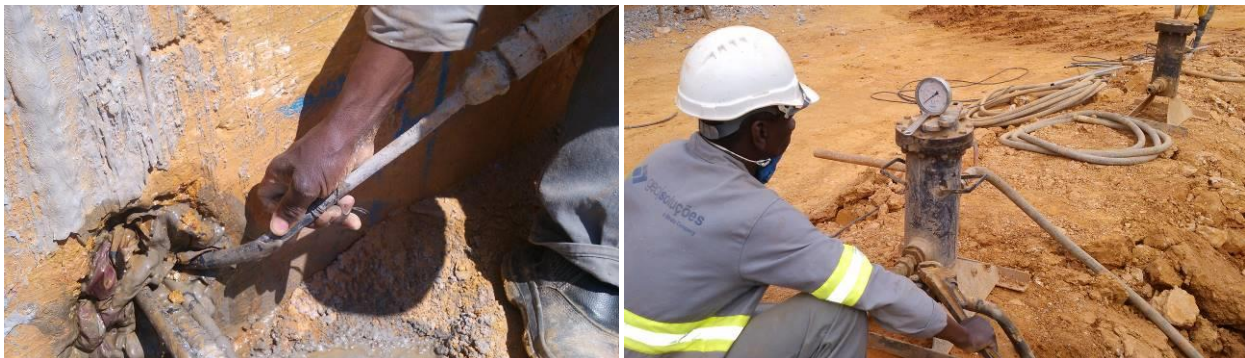
FIGURA 8: [a] Detalhe da injeção em fases, [b] Controle da pressão de injeção com pressão máxima 10 Kgf/cm 2 .
