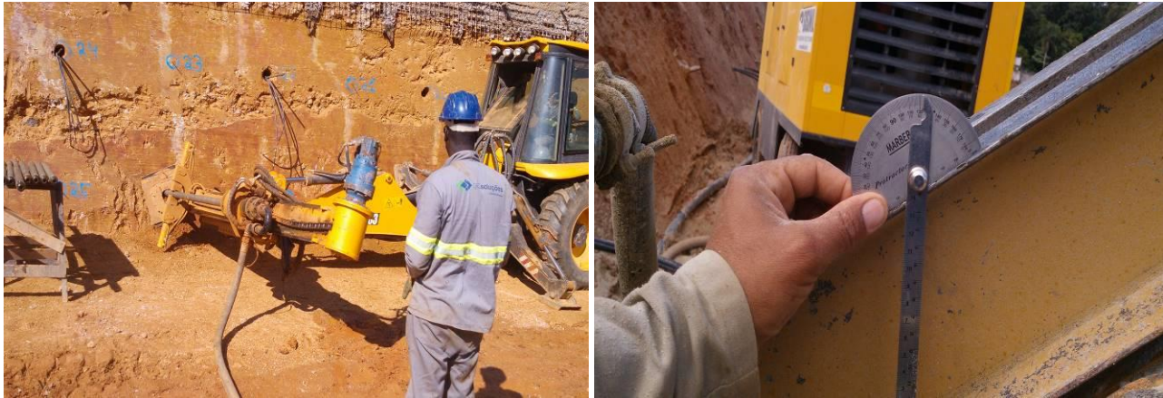
FIGURA 7: [a] Execução de chumbador teste, [b] Controle do grau de perfuração.
