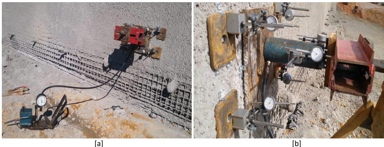
FIGURA 10: [a] Macaco hidráulico manual devidamente calibrado, [b] vista geral dos extensômetros. FONTE: Autoria própria.
