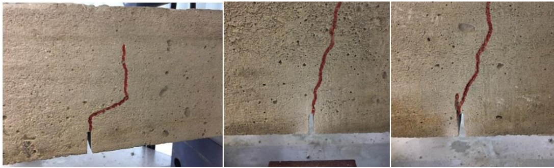
FIGURA 8: Trajetória das fissuras destacadas nas vigas 2,3 e 4 (concreto sem fibra de aço).
