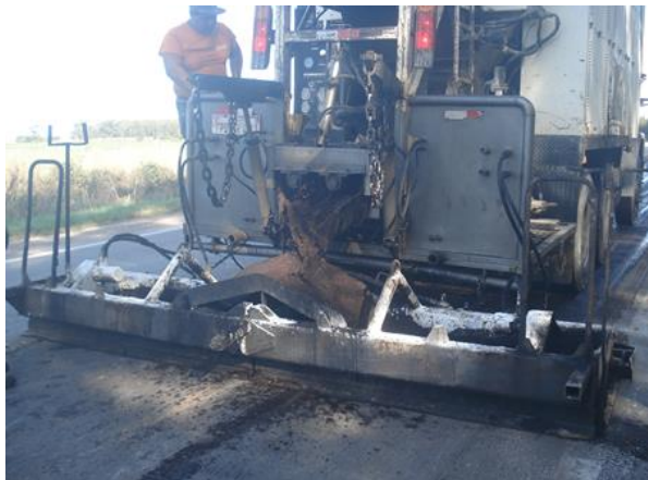
FIGURA 8: Aplicação do MRAF nas trilhas de roda utilizando usina móvel.
