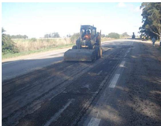
FIGURA 6: Limpeza da superfície fresada com Bobcat.
