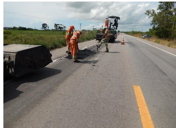
FIGURA 7: Aplicação do CBUQ nas trilhas de roda utilizando uma vibroacabadora.
