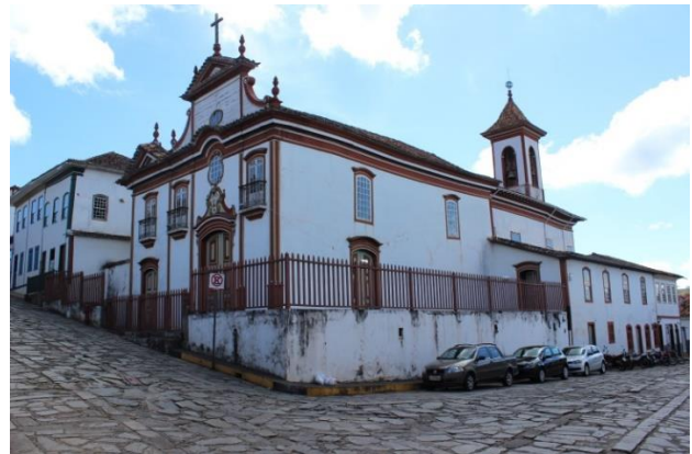
FIGURA 4: Vistas lateral e frontal da Igreja Nossa Senhora do Carmo em 2016. FONTE: Consmara (2016).
