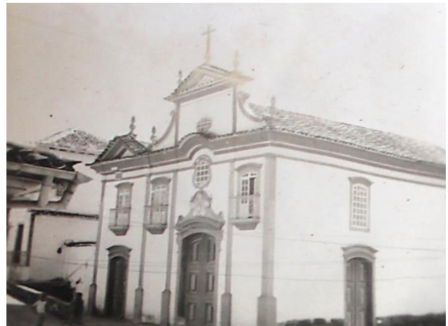
FIGURA 3: Fachada da Igreja Nossa Senhora do Carmo em 1948. FONTE: IPHAN (1979).
