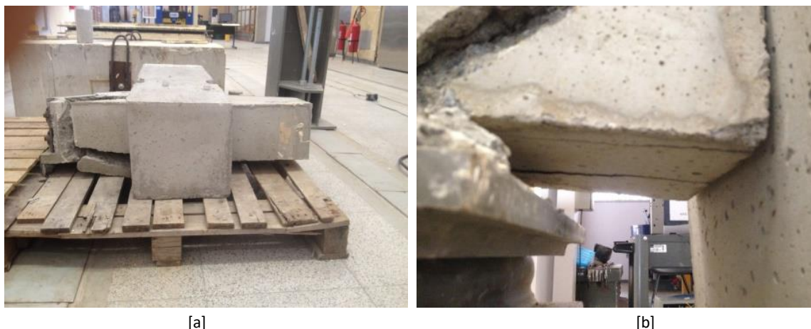
FIGURA 13: [a] Detalhes de ruptura por fendilhamento no modelo 2; [b] Detalhes de ruptura por fendilhamento no modelo 3. FONTE: Autoria própria.
