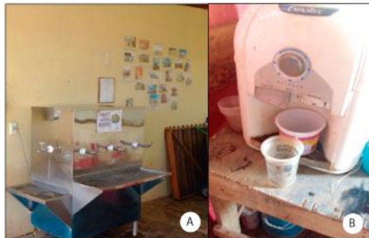
FIGURA 2: Elementos das instalações provisórias – [A] Bebedouro da obra 10 e [B] Bebedouro da Obra 7.
