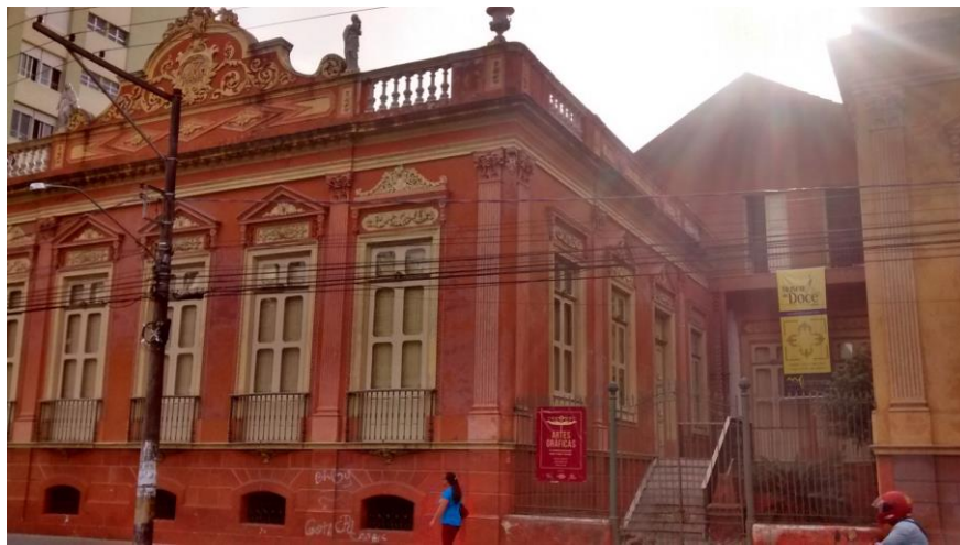
FIGURA 3: Fachada principal do Casarão 8.
