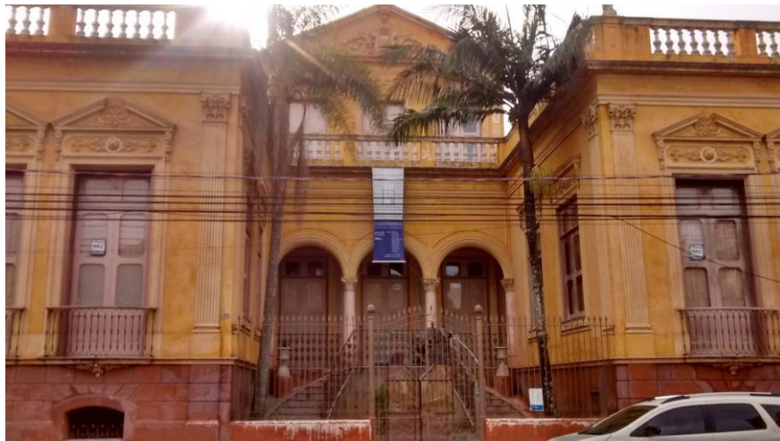
FIGURA 2: Fachada principal do Casarão 6.
