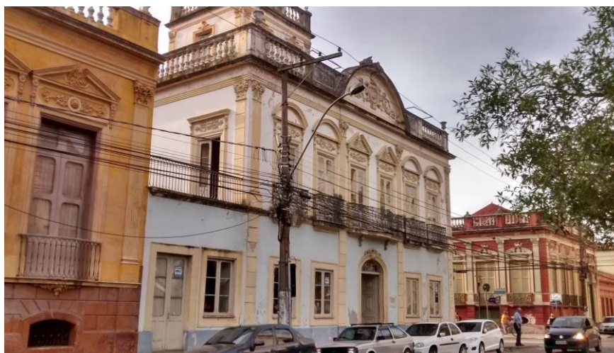
FIGURA 1: Fachada principal do Casarão 2.
