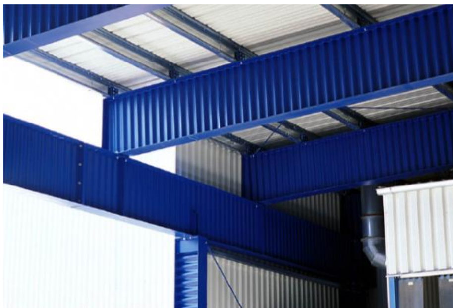
FIGURA 2: Galpão Comercial em alma corrugada, Viena. FONTE: ZEMAN & CO (2012).
