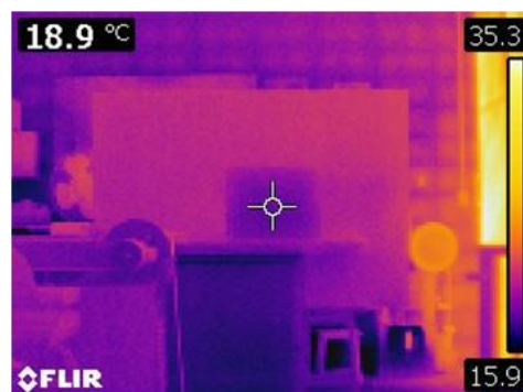
FIGURA 13: Termograma do ensaio da distância de 5 metros.
