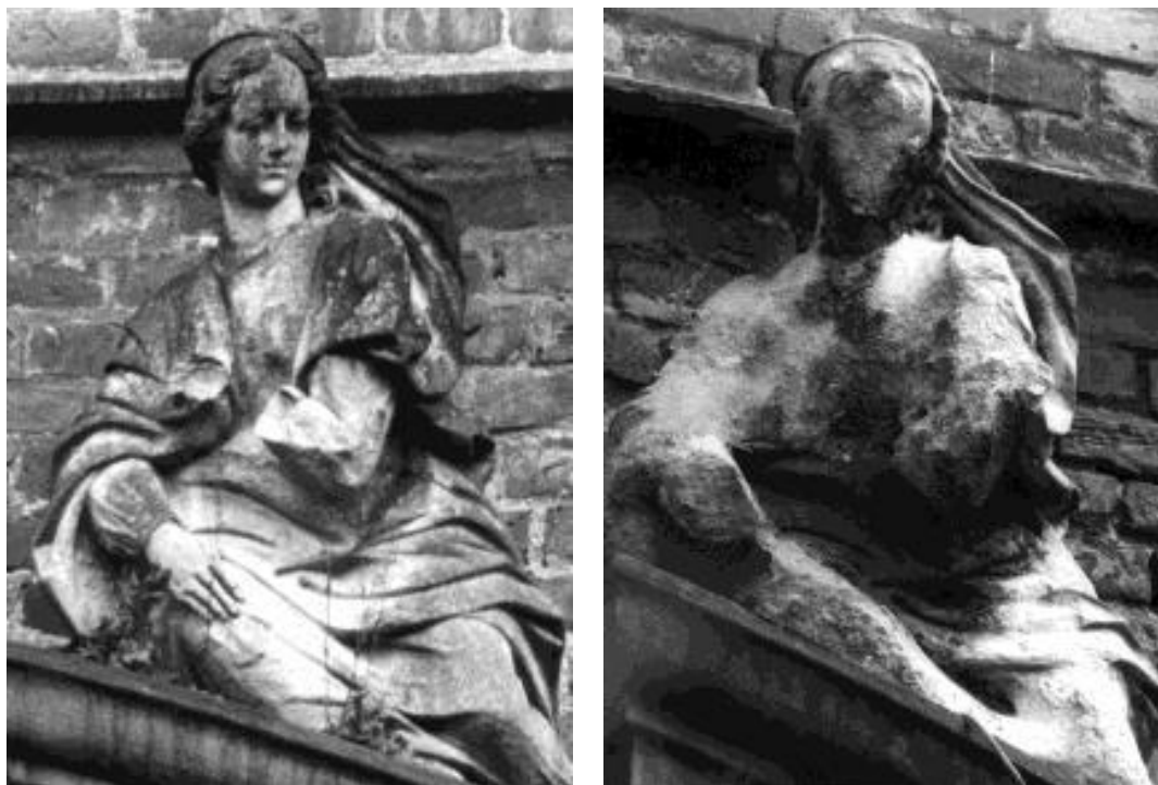
FIGURA 5: Efeito da chuva ácida após 60 anos de exposição de uma estátua de arenito sobre o portal de um castelo em Westphalia, Alemanha, fotografado em 1908 (esquerda) e novamente em 1968 (direita).
