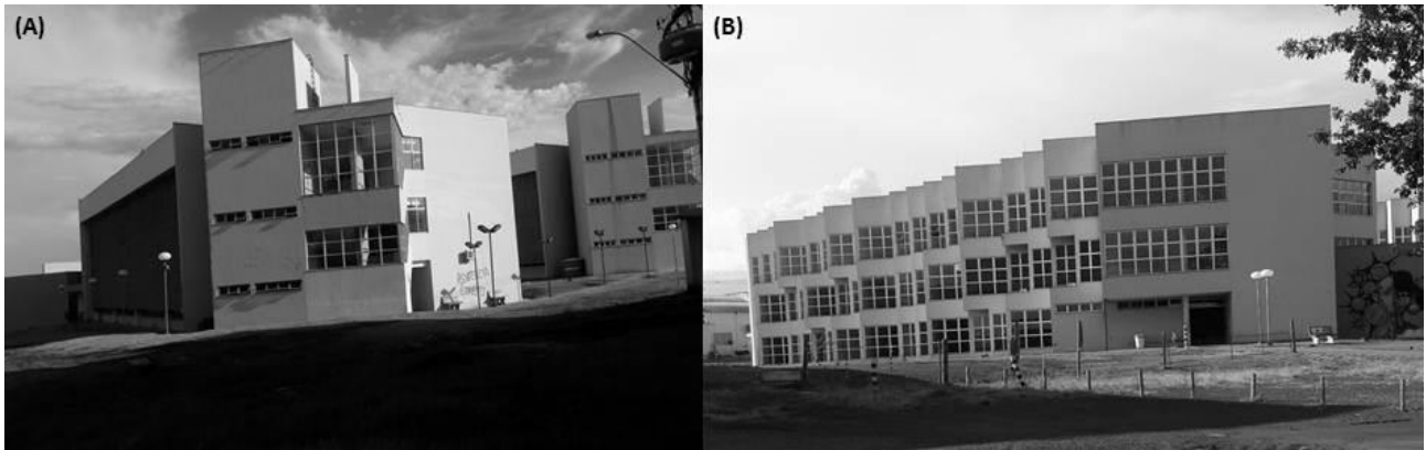
FIGURA 5: (A) Perspectiva posterior dos blocos didáticos mostrando os brises na fachada lateral direita (B) Perspectiva frontal do BD1 mostrando a fachada lateral esquerda sem proteção solar.
