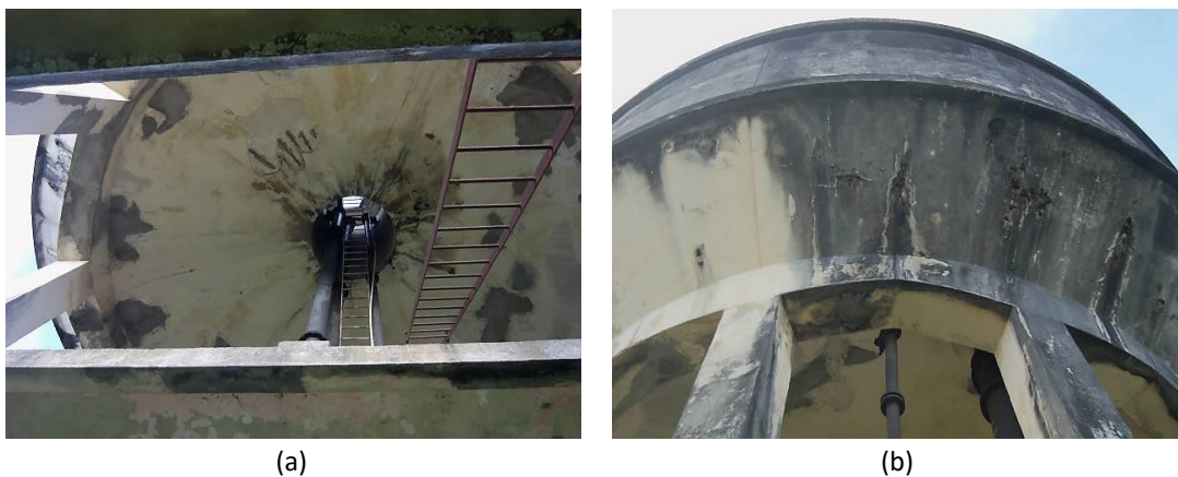
FIGURA 6: R5 T - Imagens do reservatório Bairro Fragata: (a) laje inferior; (b) vista lateral.
