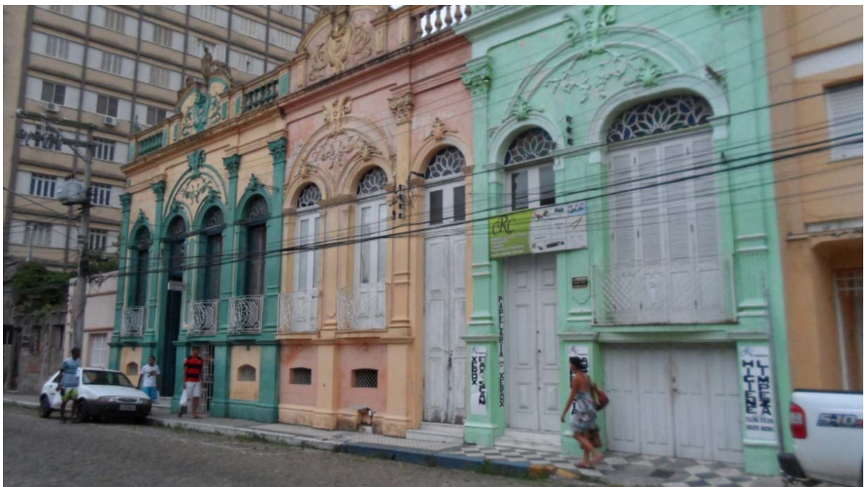
FIGURA 1: Conjunto arquitetônico construído entre 1906 e 1911 na Rua Gal. Bacelar, Rio Grande-RS.
