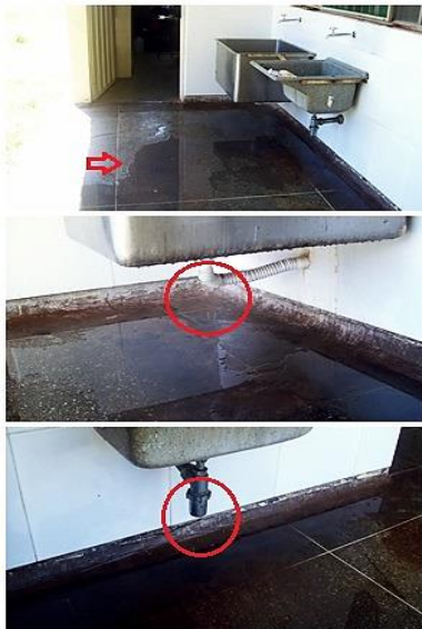
FIGURA 4: Área de serviço da escola A.
