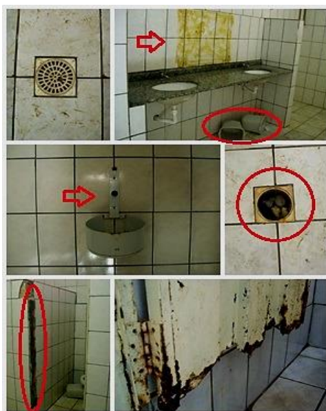
FIGURA 9: Banheiros da escola C.
