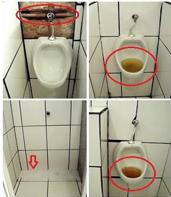
FIGURA 3: Banheiros da escola A.
