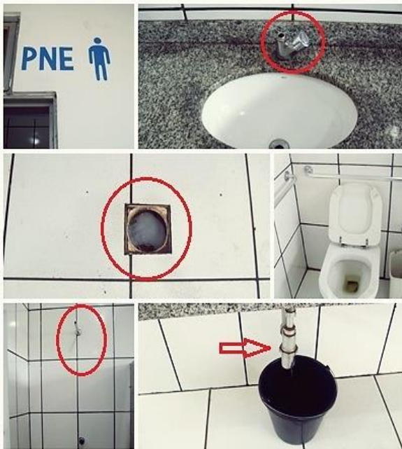
FIGURA 2: Banheiros da escola A.
