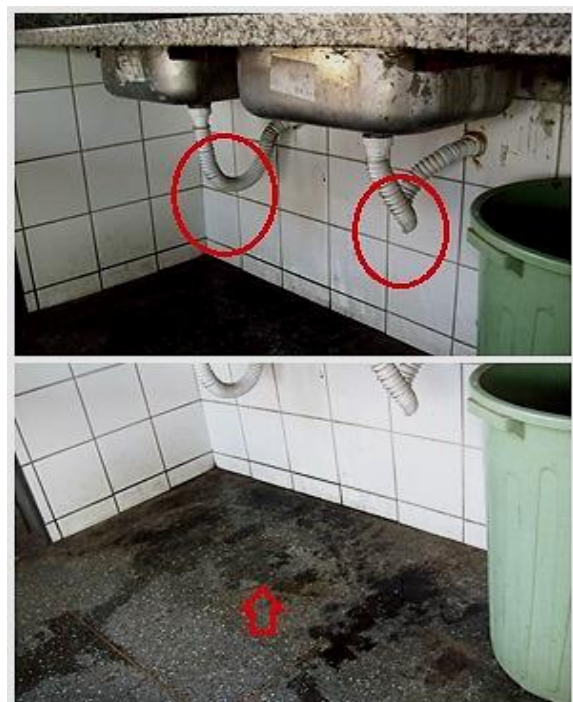
FIGURA 7: Área de serviço da escola B.
