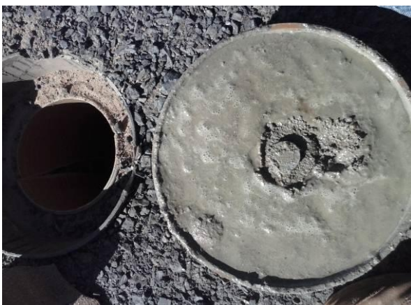
FIGURA 16: Colocação da tampa removível TIL com enchimento de concreto. FONTE: Próprio autor.
