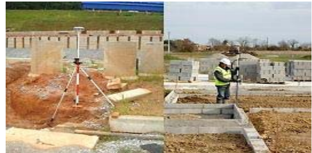
FIGURA 2: Exemplo de uso de sistema GNSS para locação em canteiro de obras. FONTE: RODRIGUES (2014).
