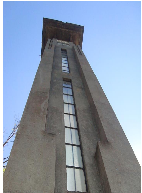
FIGURA 5: Exemplo de manchas de sujeira com lavado regular distribuídas ao longo da VISTA SUL.
