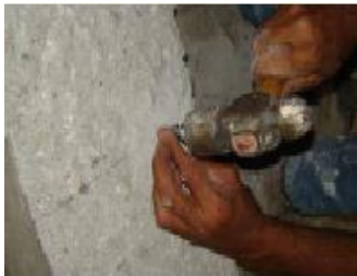
e- Instalação de conectores
