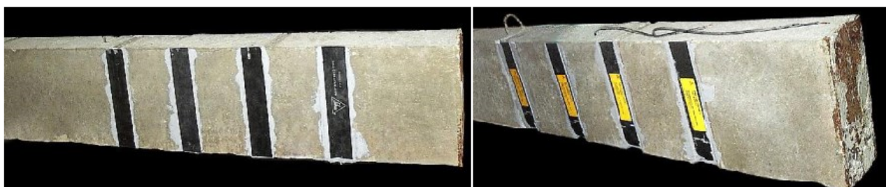
FIGURA 7: Sistemas de reforço utilizando Sika Carbodur e Sika Carbohear L.
