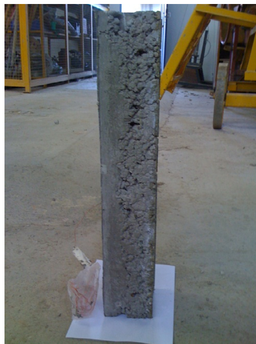
(b) Brocas de concretagem
