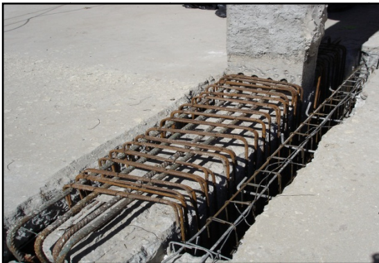
(b) Viga reforçada em todo contorno (encamisamento total).
