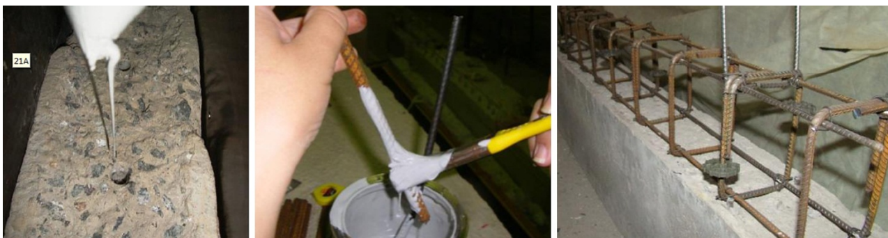
Figura 5: (a) aspecto da superfície escarificada, (b) aplicação de resina epóxi em um conector "I", (c) armadura de confinamento posicionada em uma viga.
