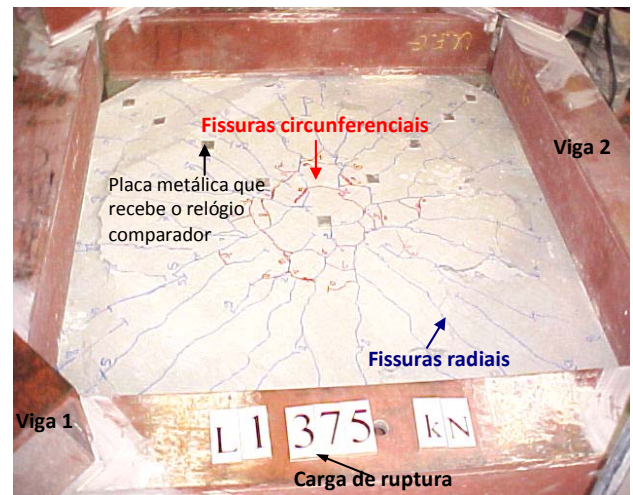
Figura 6: Fissuração da Laje L1
