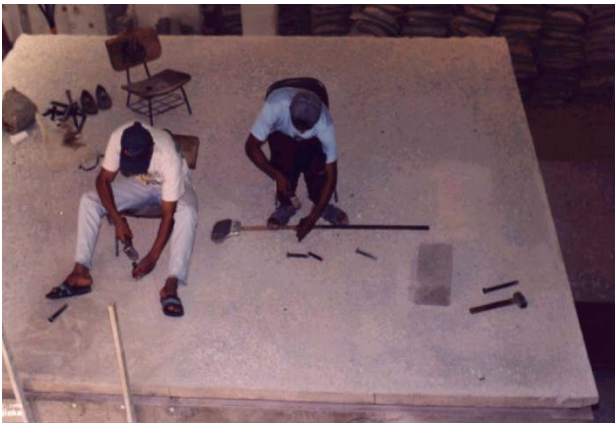
Figura 5: Fotografias da execução do apicoamento manual.
