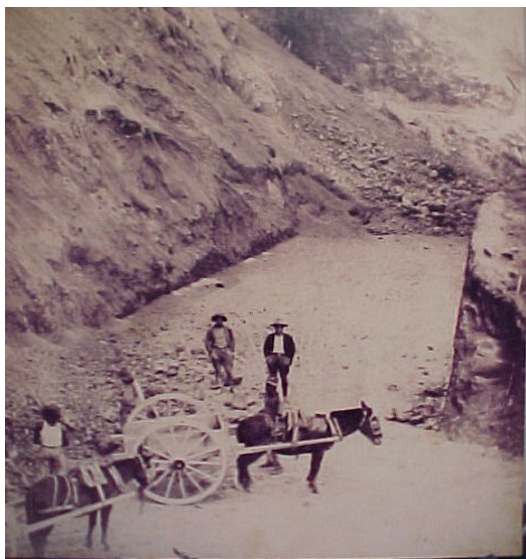
Figura 1: Reforma e ampliação do trecho de Cubatão a São Bernardo do Campo. Queda de barreiras em uma “cava” manual com transporte do material em carroças de burros (fotografia cedida pela empresa CBPO).
