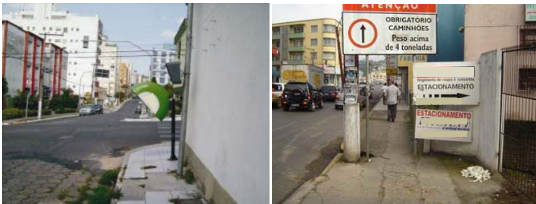
Figura 1: Telefone público e placas de estacionamento como obstáculos na calçada Fonte: Dorneles e Zampieri (2008).
