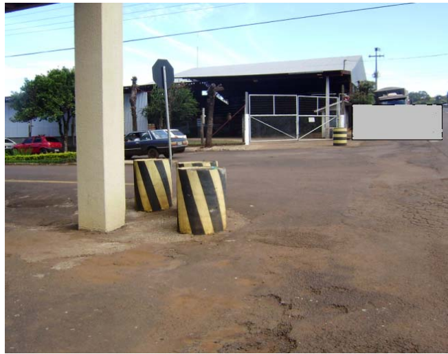
Figura 3: Barreiras “bem resistentes” em ambas as esquinas, inibindo o trânsito na calçada.
