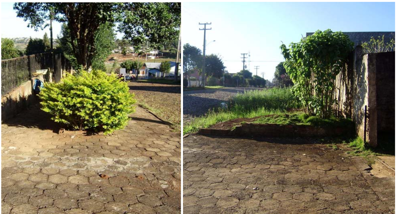
Figura 5: Calçadas obstruídas e desniveladas impossibilitando a passagem de pedestres.
