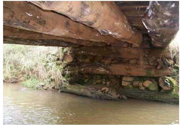
Figura 9: Estiva - Vista de sistema de apoio da Ponte F.
