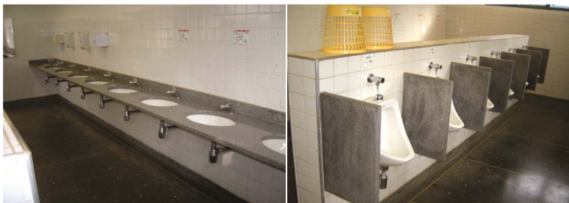
Figura 45: Lavatórios e mictórios do banheiro masculino que só é aberto durante eventos no edifício.
