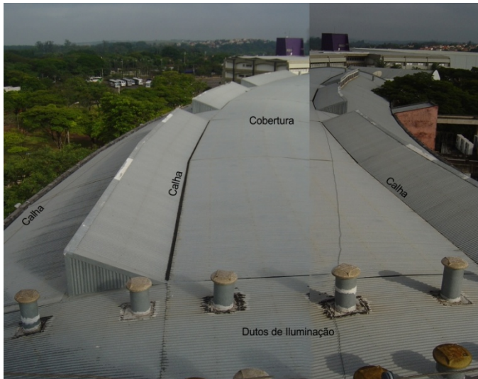
Figura 48: Cobertura observada de cima do reservatório superior do Ciclo Básico II – Unicamp.
