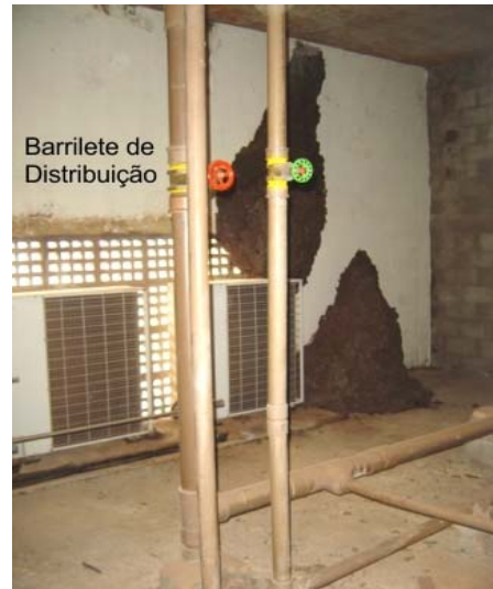
Figura 49: Barrilete de distribuição de água fria.
