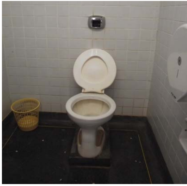
Figura 39: Foto da bacia que apresenta problemas de vazamento na válvula de descarga.
