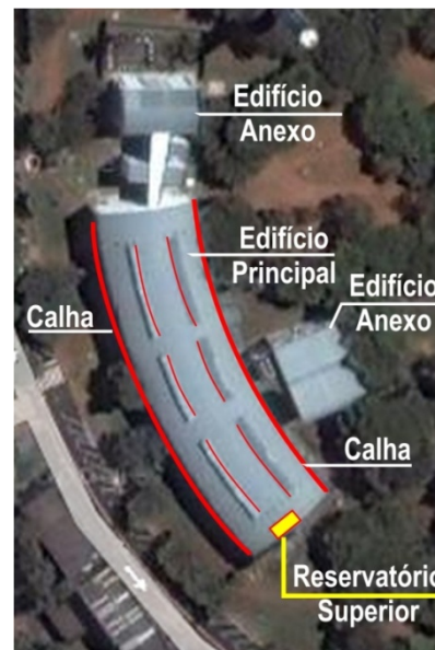
Figura 9: Foto aérea do Ciclo Básico II com destaque do edifício principal, reservatório e calhas.
