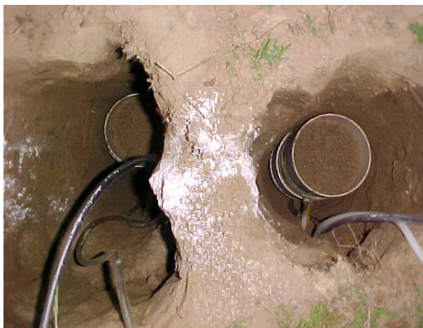
Figura 6: Instalação dos coletores no centro das parcelas, a 0,25, 0,50 e 0,75 m de profundidade.
