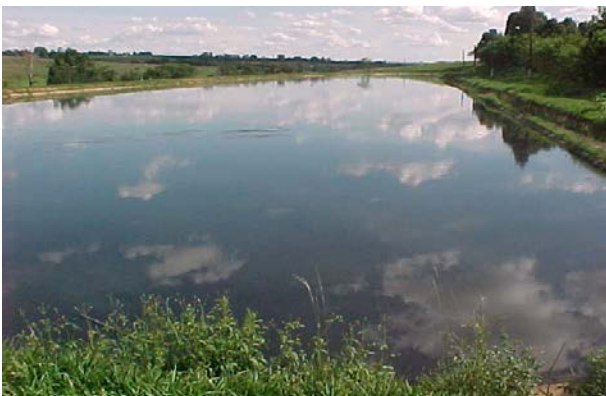
Figura 2: Lagoa anaeróbia que recebe o esgoto doméstico do bairro da Graminha em Limeira/SP.
